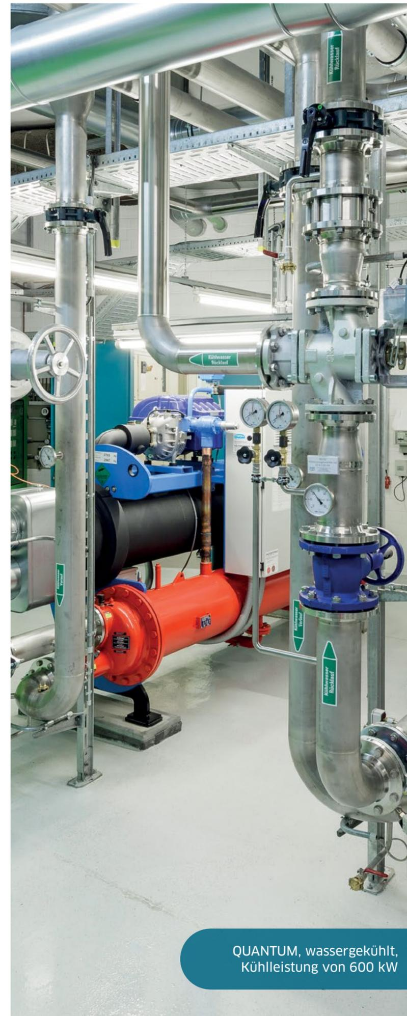
QUANTUM, wassergekühlt, Kühlleistung von 600 kW
